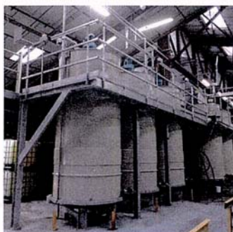
La nouvelle plate-forme compte 2 cuves de 11.000 litres et 3 cuves de 7.500 litres.
