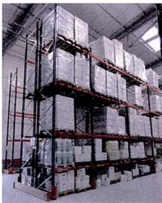
La capacité totale de stockage a presque doublé avec le nouveau bâtiment, d'une surface de 900 m 2 .
